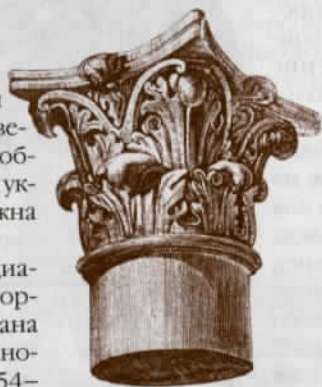
Части колонн херсонесских храмов
