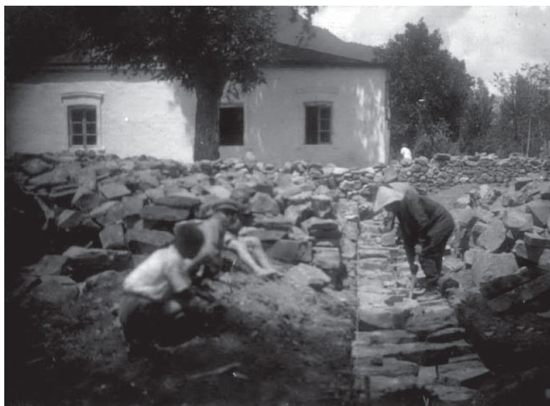
Закладка фундамента здания школы в с. Бахурхеви. 1928 г.
